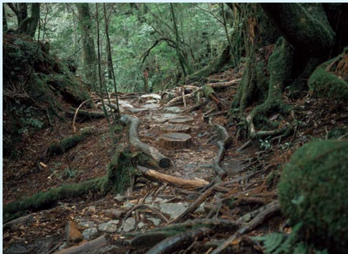
近自然工法で整備された登山道。自然の地形や水の流れを生かしながら、人工物を用いずに登山道を安定させる
